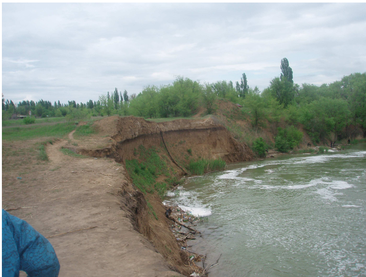
Рисунок 2 – Оползневые процессы на концевом сбросе в Садковскую балку
