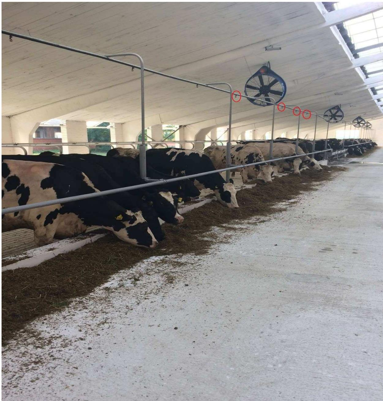
Рисунок 2 – Форсунки для распыления воды туманом
